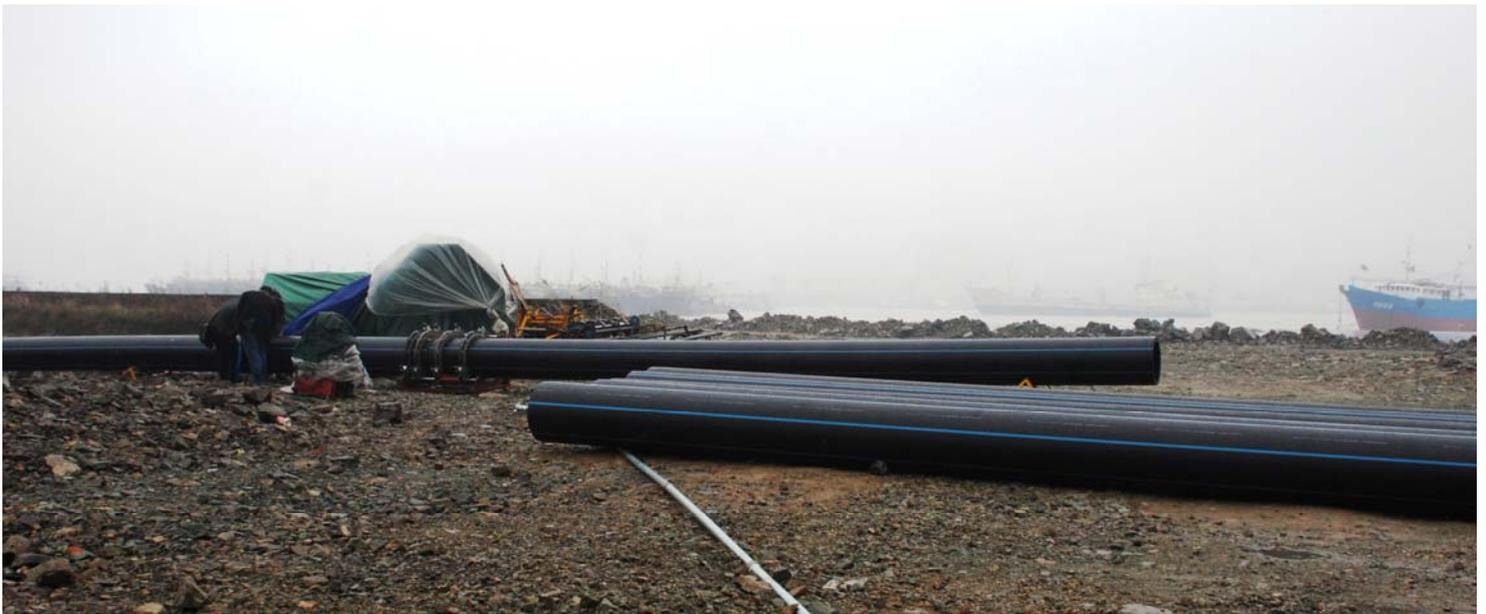
随着海床下的淡水管道系统的建成，舟山群岛每日的淡水输送量递增至 **35 万吨**。在十至二十年之后，经扩展的管道系统将会为岛上 **85%** 的居民提供新鲜的饮用水；这都是拜一项以非开挖技术安装在海床下的淡水管道所赐，用作生产这管道的材料为 **Hostalen CRP 100 黑色树脂**，由领先业界的聚烯烃生产商利安德巴赛尔生产的 **PE 100 压力管道材料**。
